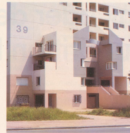
»Durchgreifende Rehabilitation an einem »Pascal-Turm« in »Les Minguettes«, Lyon«
