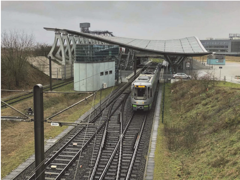
Abb. 3 Stadtbahn-Endpunkt Messe Ost, künftiges Eingangstor zum neuen Stadtteil Kronsberg-Süd
