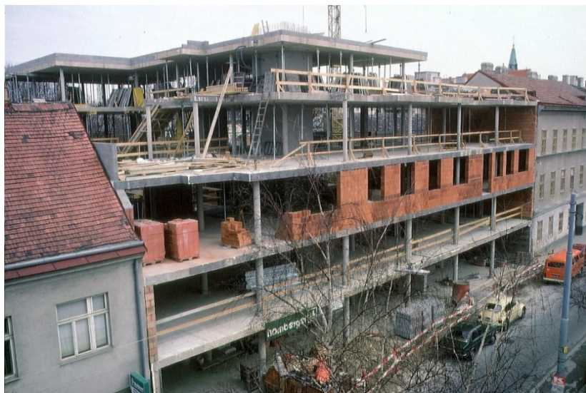
Abbildung 1: Das B.R.O.T.-Haus während des Baus, die Stützenbauweise ist noch gut erkennbar. (Foto: Gemeinschaft B.R.O.T. Hernals)
