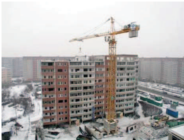
18a e 18b: Desmontagem (Rückbau) de antigos edifícios pré-fabricados da RDA no âmbito do programa de renovação (Sanierung/Modernisierung) de Marzahn-Hellersdorf (2004). A renovação de Marzahn-Hellersdorf fez parte do plano de modernização nacional das ex-cidades Orientais (Stadumbau Ost). Foto: Klimbemann.
