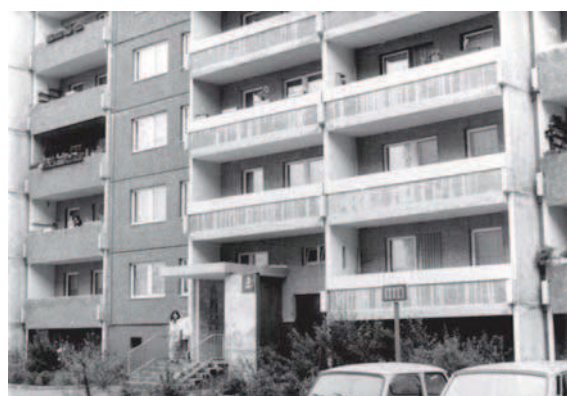
17: Detalhe do edifício residencial na Rosenbecker Strasse em Marzahn (1990). Foto: Bundesarchiv, Bild: 183-1990-0611-020
