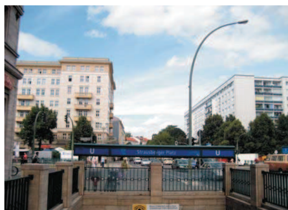
10: Edifícios residenciais após renovação (2013). À esquerda Fase 1, à direita Fase 2, ao centro estação de metrô. Foto: Arquivo pessoal Cintia Alves
