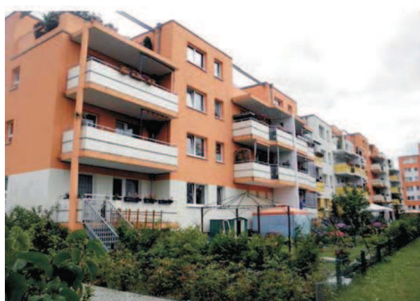
20: Exemplo de renovação-modelo em Marzahn - Ahrensfelder Terrassen (2006). A desmontagem de antigos edifícios pré-moldados de 11 e 6 andares originou em média edifícios de 3 pavimentos com terraços individuais e jardins no térreo. No âmbito deste projeto, implementado entre 2004 e 2009, dos 4.632 antigos aptos, 3.538 foram desmontados, o restante modernizado. Foto: Senatsverwaltung für Stadtentwicklung. Stadumbau in Berlin – Monitoringbericht 2010, 2010, p. 43
