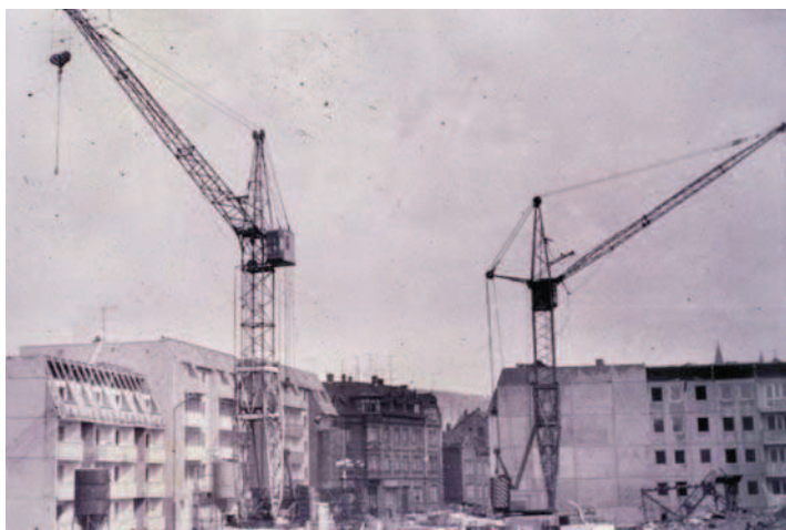
4: Canteiro de montagem no centro histórico de Halle
