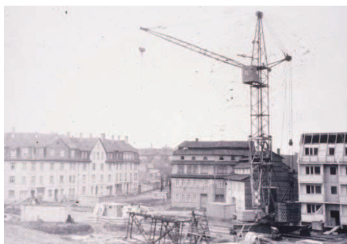
3: Canteiro de montagem no centro histórico de Halle
