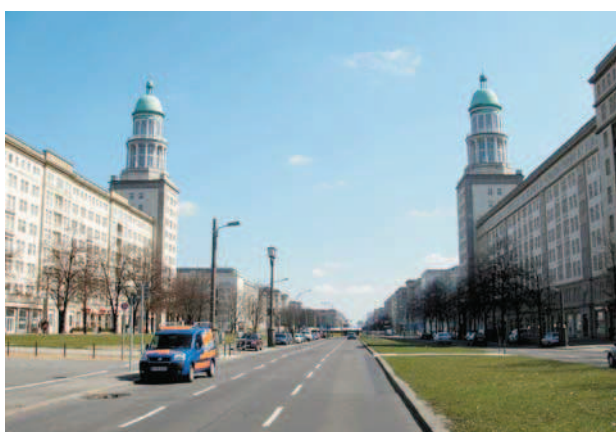
9: Fase 1 – Frankfurter Tor e Bloco F pós restauro (2008). Foto: Arquivo pessoal Cintia Alves.
